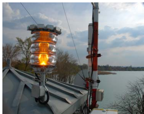
2. ábra: Az első szériában alkalmazott viharjelző lámpák egyike (bal oldalon), a villogó fényt forgómotor hajtotta tükör biztosította. Modern ledes viharjelző lámpa az Obszervatórium tetején (jobb oldalon).
