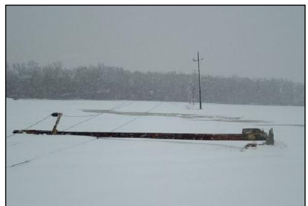
25. ábra: A vezetékekre lerakódó vastag, tömör hó- és jégréteg miatt villanyoszlopok dőltek ki (forrás: Kolláth és Tóth, 2009).
