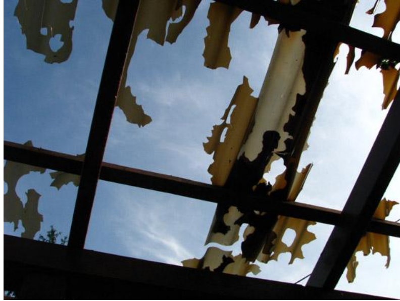
44. ábra. Jégeső által darabokra tört palatető (www.idokep.hu).
