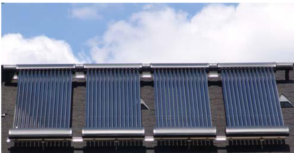
8. ábra: Vákuumcsöves napkollektor
