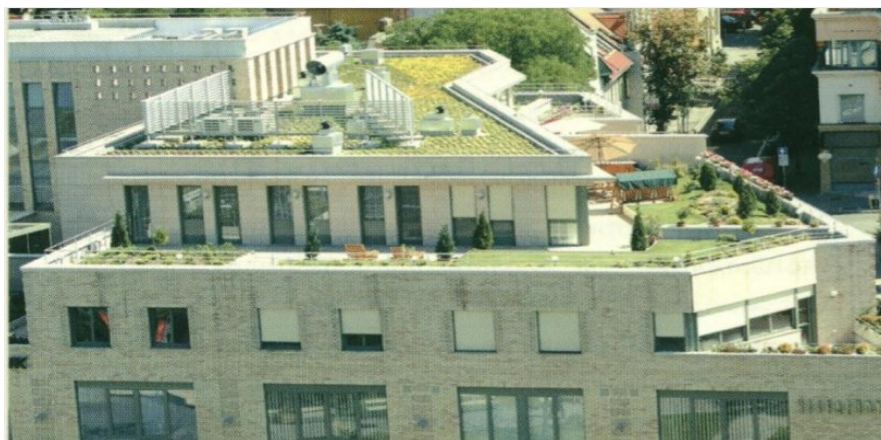
3.2.1. ábra: Egy épület tetején kialakított extenzív és intenzív tetőkert (Kecskemét, Kisfaludy ház)
