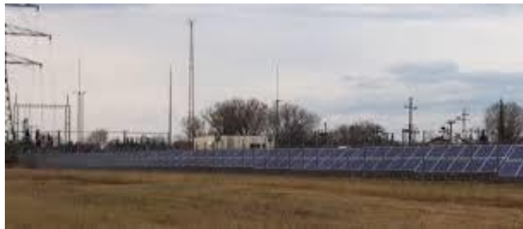
21. ábra: Kisteleki fotovoltaikus naperőmű részlete (Körös Consult)
