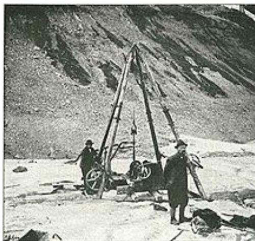
3. ábra: Hans Hess által használt fúró (Forrás: Blümcke and Hess, 1910)
